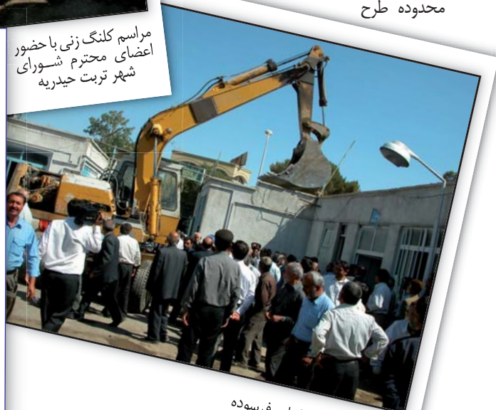
مراسم تخریب بناهای فرسوده
