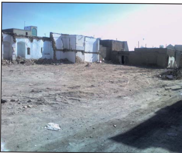
آماده سازی زمین جهت شروع پروژه
