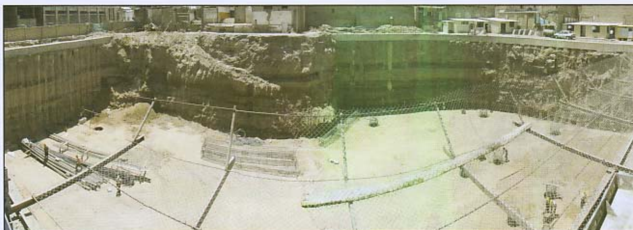
پیشرفت فیزیکی پروژه ایمان
