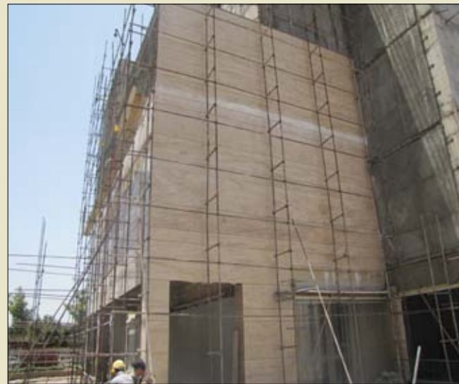
آغاز اجرای نمای سنگ
