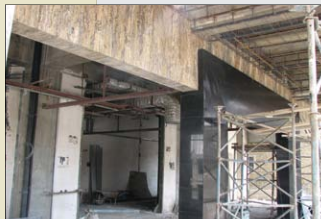
آغاز اجرای نمای سنگ
