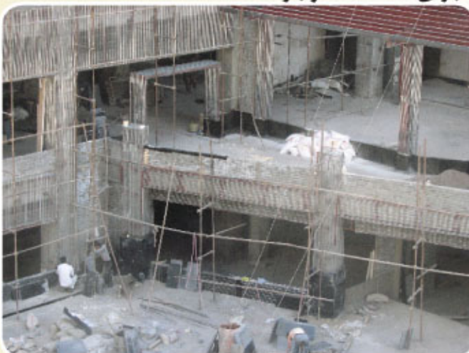
اجرای سنگ نما در بلوک ۱
