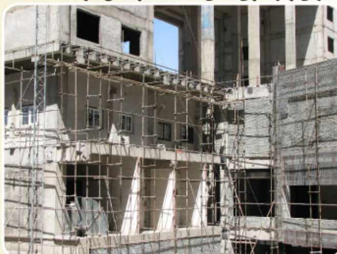
اجرای زیرسازی نمای سمت شارستان بلوک ۲
